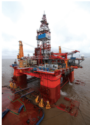
Die modernste Ölplattform 981 von CNOOC und CSIC
