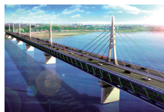
Brücke über den Gelben Fluss in Zhengzhou
