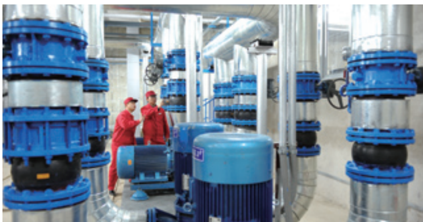
Система геотермального отопления построена на основе использования геотермальных ресурсов
