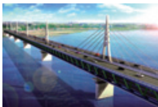
Puente sobre el Huanghe en Zhengzhou de uso doble para la carretera y el ferrocarril
