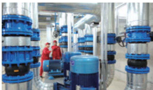
Chauffage central à base géothermique.
