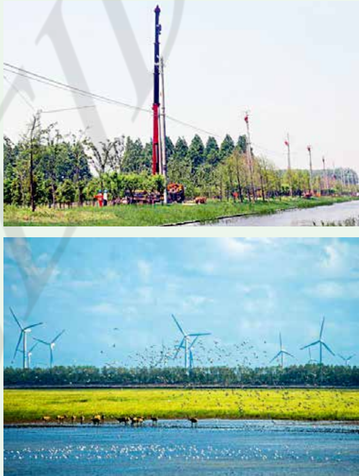
图 1 将输电线路改造为电缆入地
