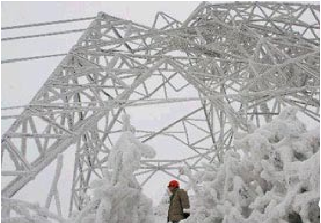
结冰的高压线——拉倒了钢铁塔架；
