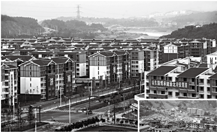
2008年5月12日四川汶川地震中，北川是受灾最重的地区之一，县城几乎被夷为平地。2010年9月25日，由山东省援建北川的所有项目全部竣工，并整体移交给北川县。图为北川新县城安居房一角。
