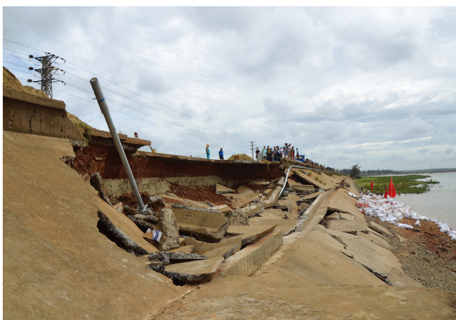
图4 广东省徐闻县和安镇堤坝被损毁 拍摄时间: 2014.7.19 16:00 坐标:20°38'N, 110°23'E
