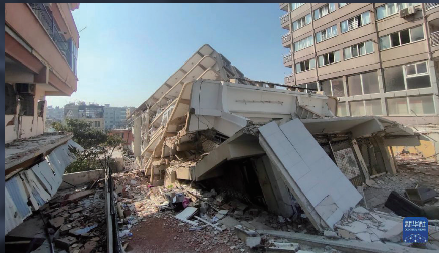
▲ 这是2月13日在土耳其哈塔伊省安塔基亚市拍摄的因地震损毁的建筑物。
