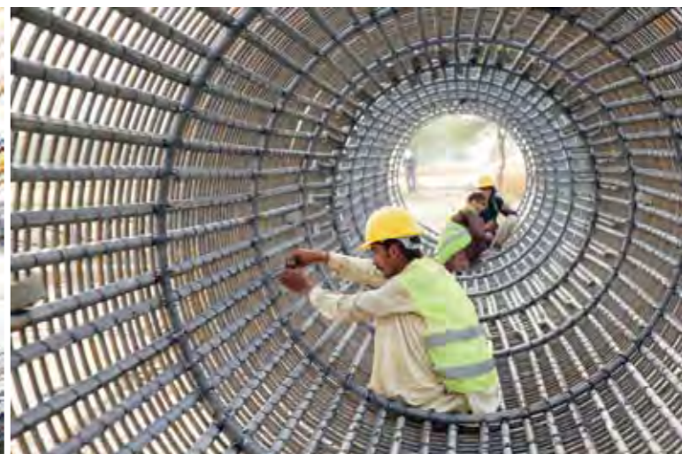
2017年4月21日,巴基斯坦工人在白沙瓦至卡拉奇高速公路(木尔坦至苏库尔段)的一处工地施工。由中国建筑股份有限公司承建的白沙瓦至卡拉奇高速公路(木尔坦至苏库尔段)全长392公里,是中巴经济走廊最大的交通基础设施项目。 摄影 刘天/新华社
