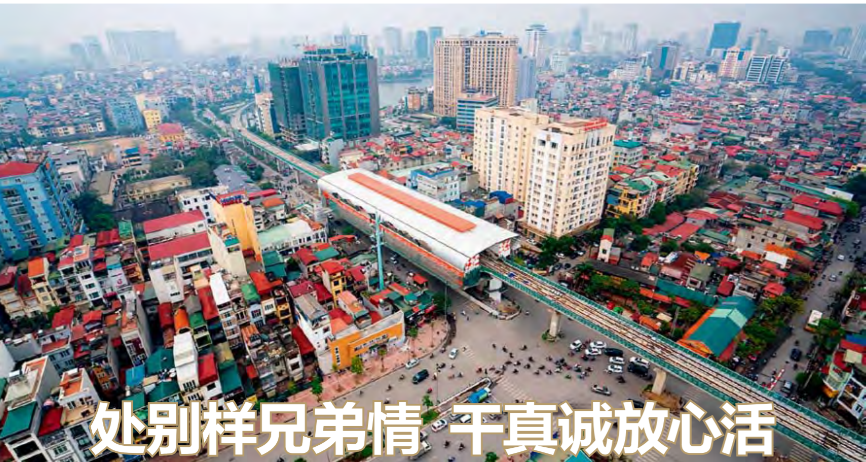
2017年3月，越南首都河内，正在建设中的吉灵—河内线轻轨。新华社 供图
