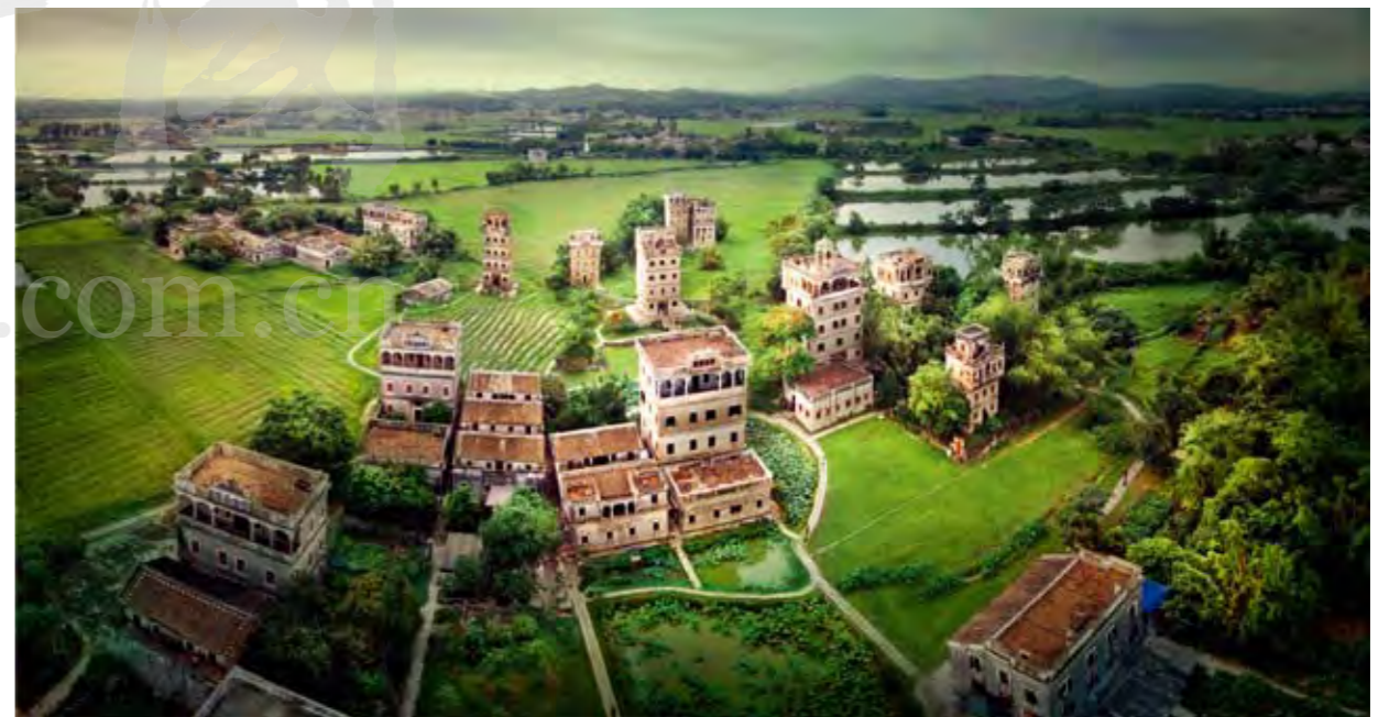
自力村碉楼群位于中国广东省开平市塘口镇,是世界文化遗产之一。开平碉楼现存1800多座,大多兴建于上世纪二、三十年代,是当地民众按照自己的意愿选取不同的外国建筑式样综合在一起建成的,成为了独特的世界建筑艺术景观,体现了近代中西文化在中国乡村的广泛交流。 摄影 许晖
