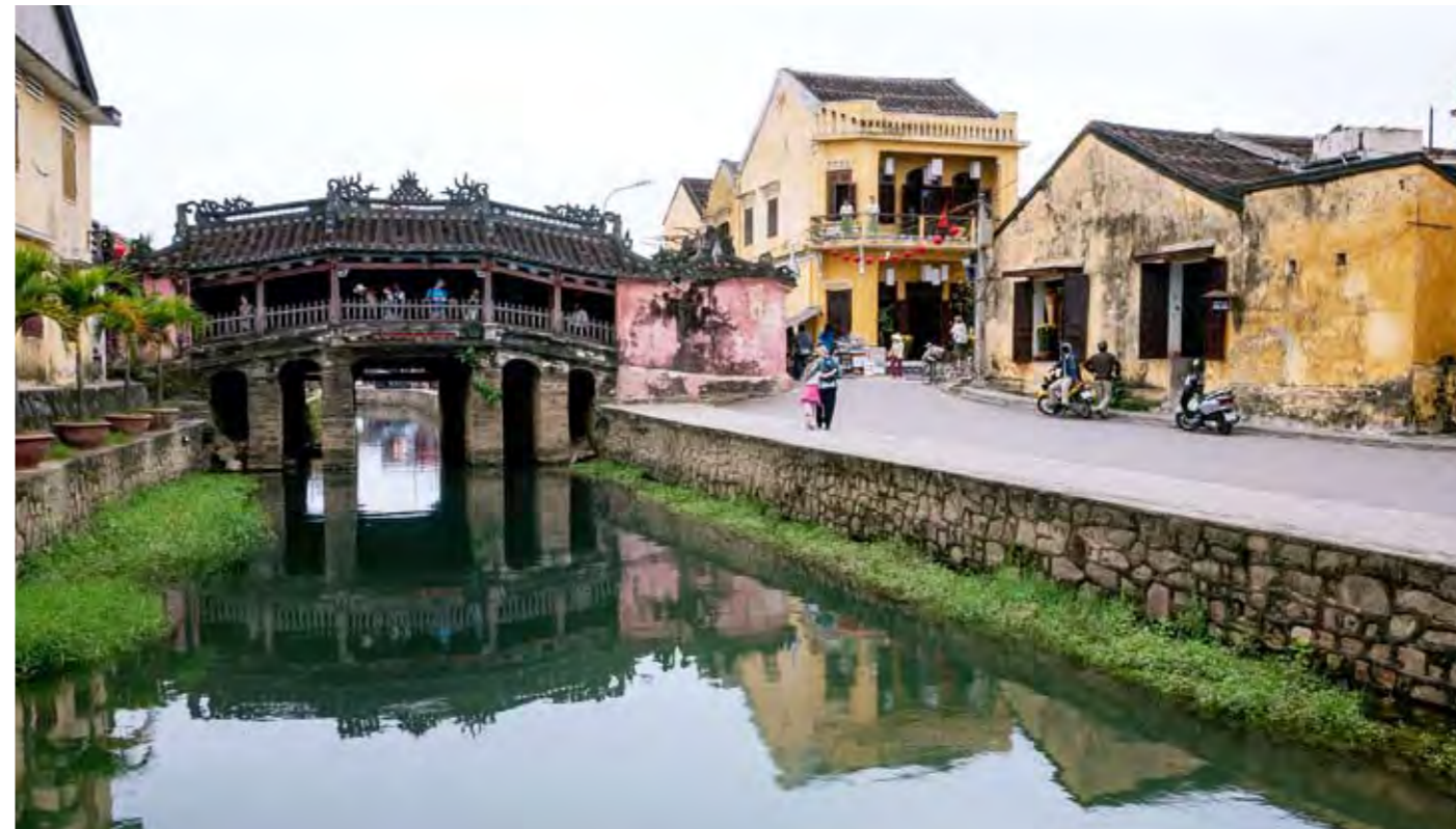
来远桥，位于越南会安，是一座桥与寺结合的古建筑，也是被列为世界文化遗产的会安城中具代表性的建筑之一。 摄影 金向/人民画报
