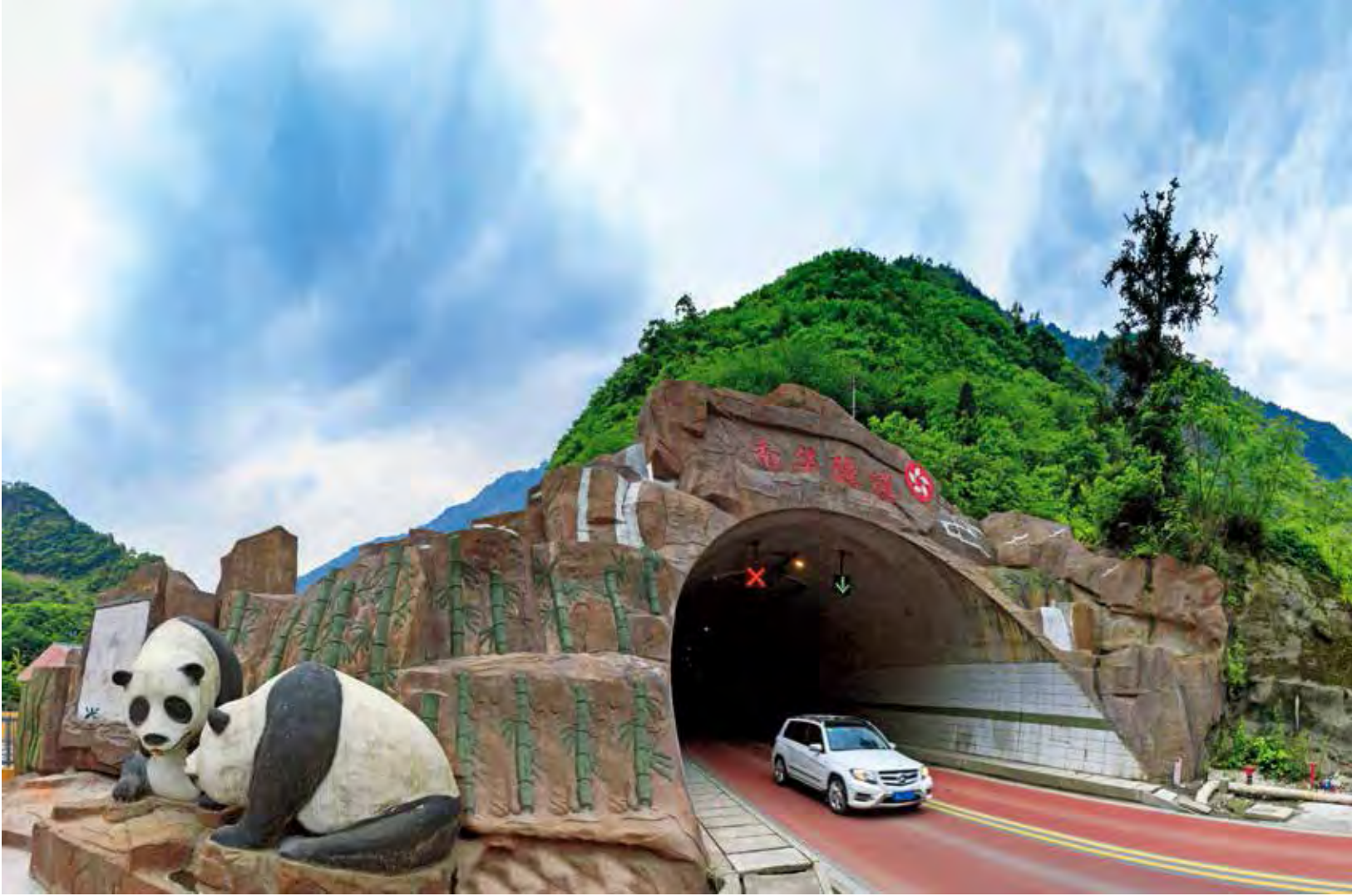
省道 303 线南华隧道
