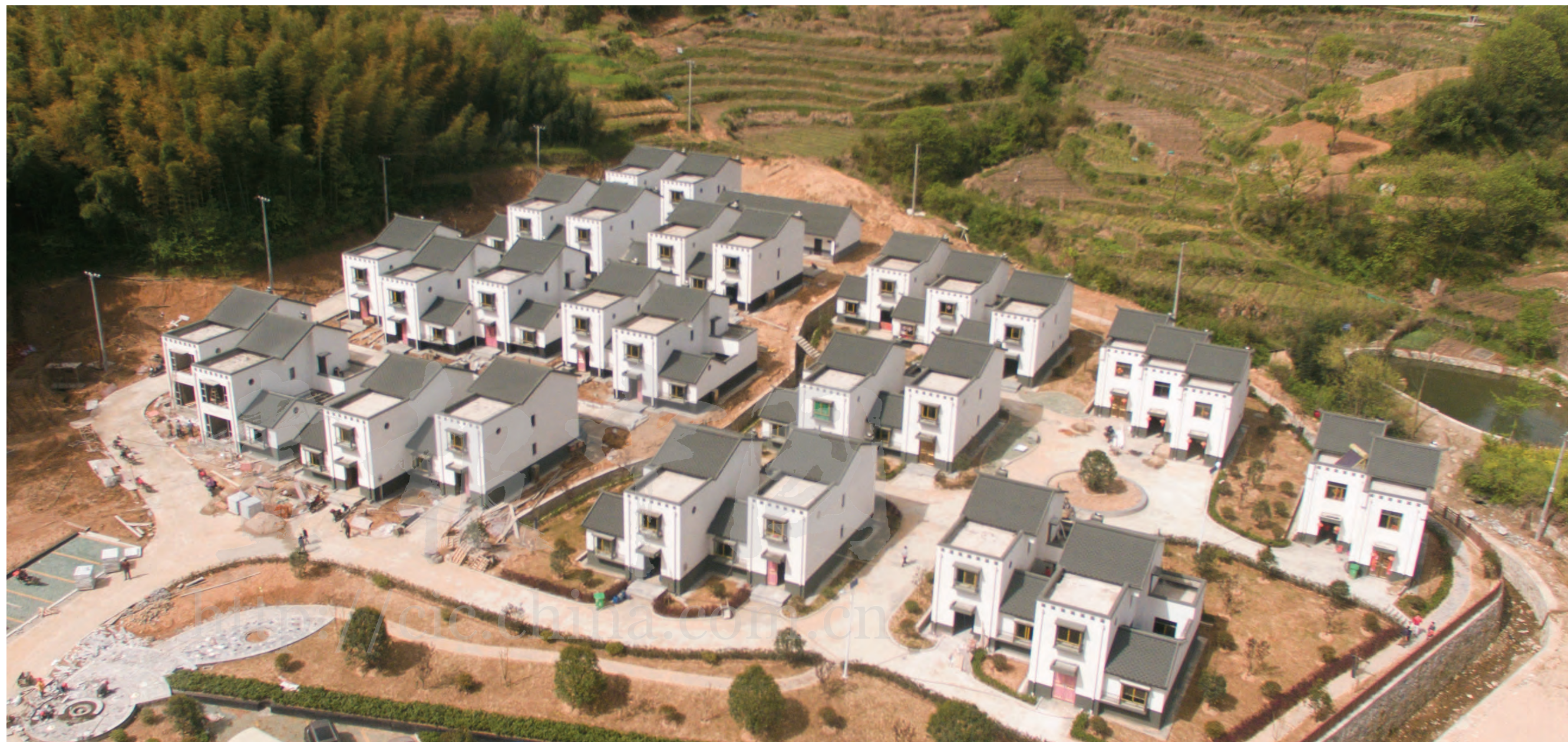
2017年4月10日，已建成的金寨县花石乡大湾村大湾扶贫移民安置点
