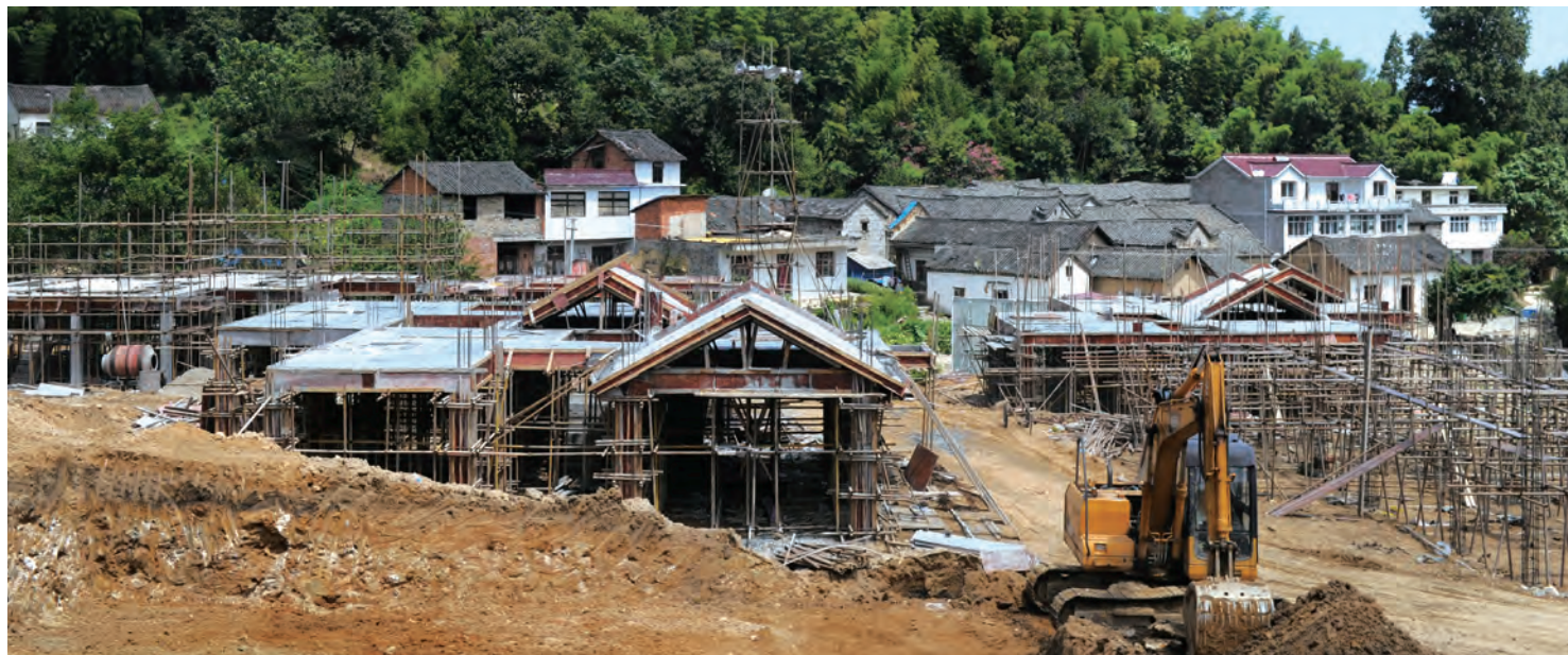
2016年8月13日，金寨县花石乡大湾村大湾扶贫移民安置点正在施工建设中
