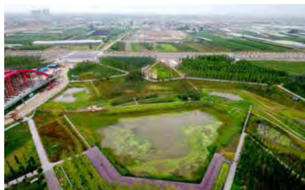
“海绵城市”试点区西咸新区沣西新城安然度过大暴雨袭击（新华社刘潇摄）
